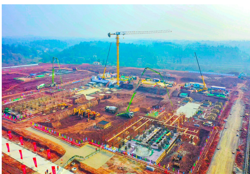
项目建设现场。
