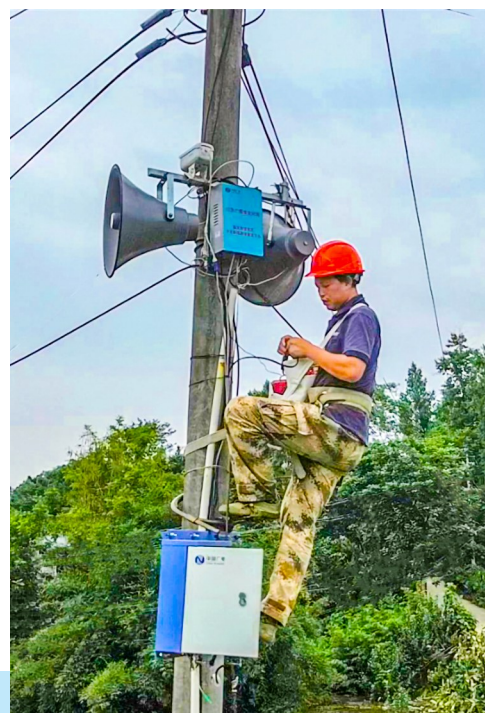
▶ 工作人员安装调试应急广播喇叭。
