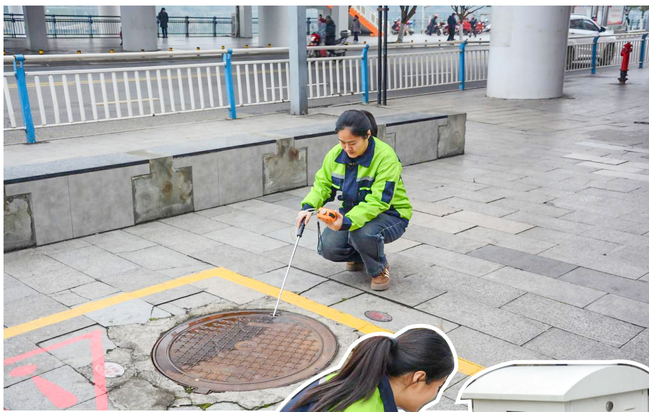
▲ 对化粪池进行检查。 ▶ 工作人员检查智能处置系统。
