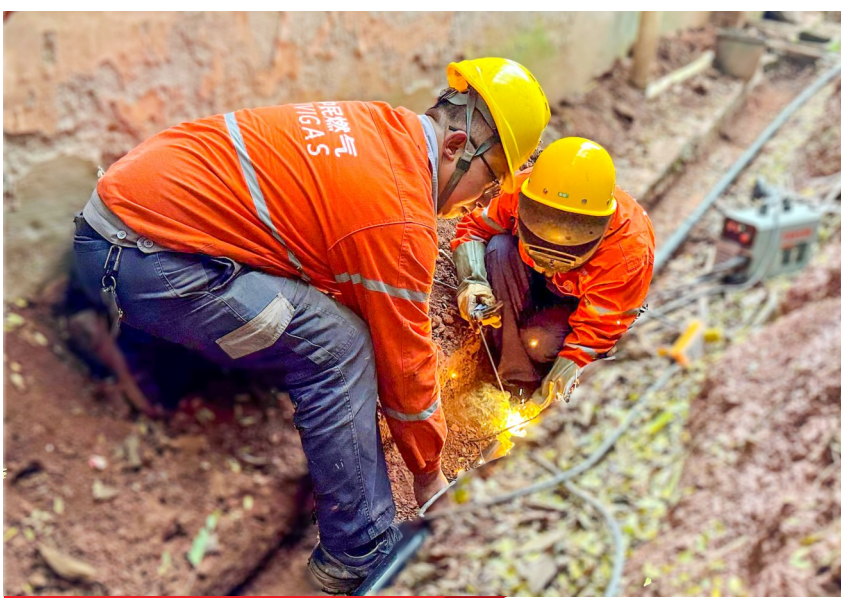
燃气工人正在铺设天然气管道。
