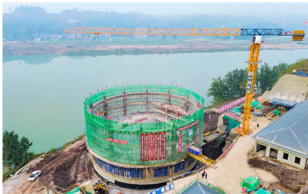
渝西水资源配置工程桂林泵站施工现场。
