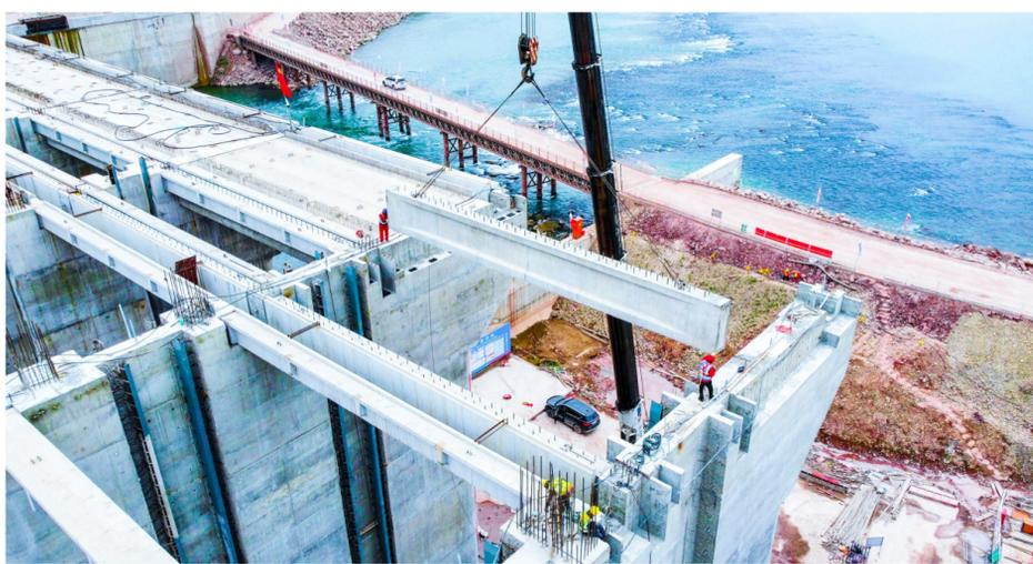
工程建设现场，工人们在道闸墩上安装一箱重达32吨的预制梁。
